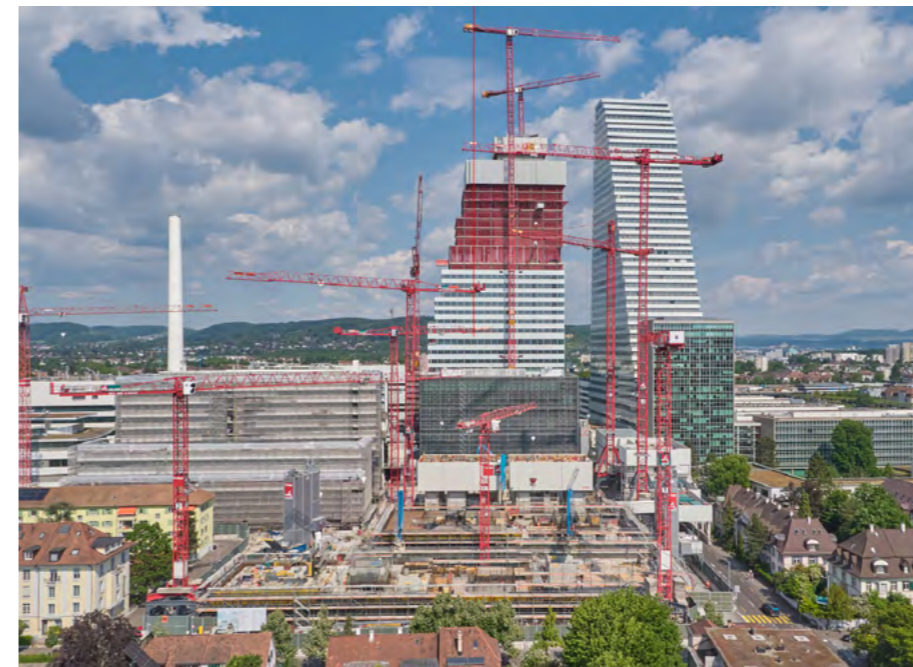
Blick auf die Grossbaustelle aus der Vogelperspektive ©Beat Ernst
