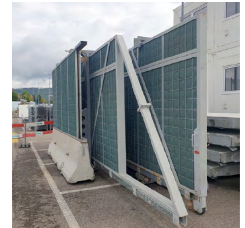
Schiebetore und Lärmschutzelemente
