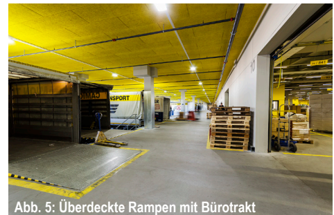
Abb. 5: Überdeckte Rampen mit Bürotrakt
