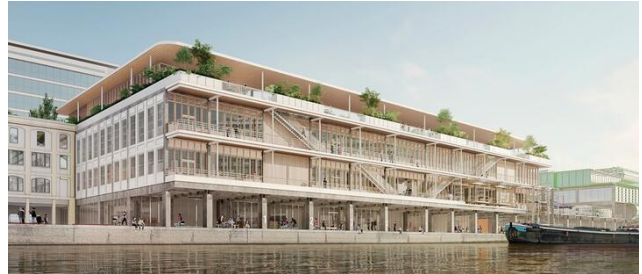
Abb. 14: Projekt «Les Amarres» von Sogaris am Hafen von Austerlitz in Paris (geplante Fertigstellung 2026)
