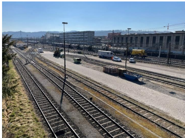
Abb. 33 Bestehende Güteranlage Winterthur GB (Quelle: Rapp AG)
