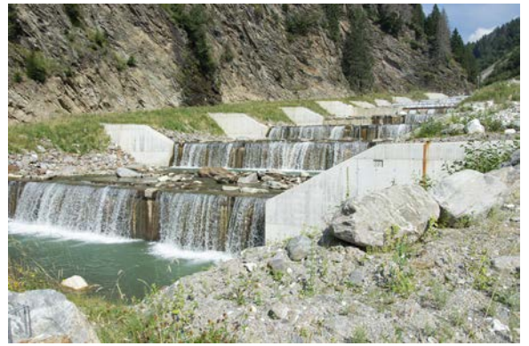
Retentionsbecken und Verbauungen minimieren die Schadenswirkung von Hochwasser und Murgängen.
