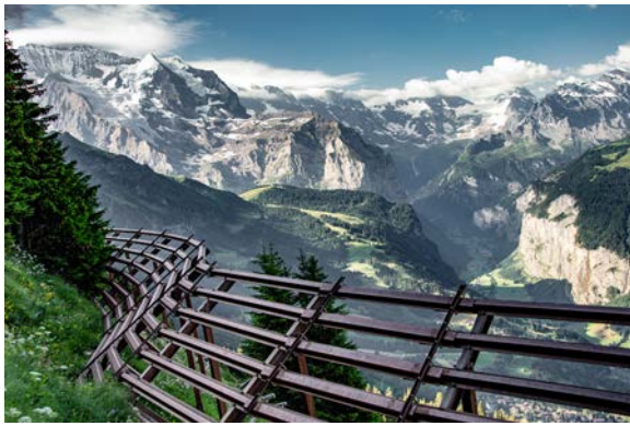
Stahlschneebrücken werden häufig in Hängen eingesetzt, um den Anbruch von Lawinen zu reduzieren.
